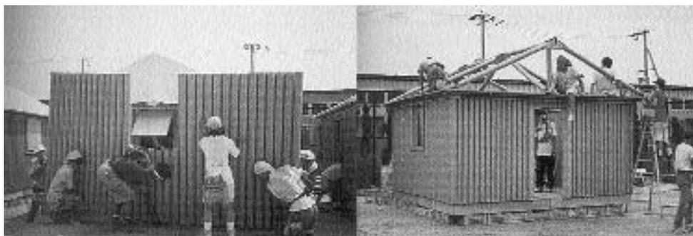
Fig. 23. Fasi di montaggio della Paper Log House.
